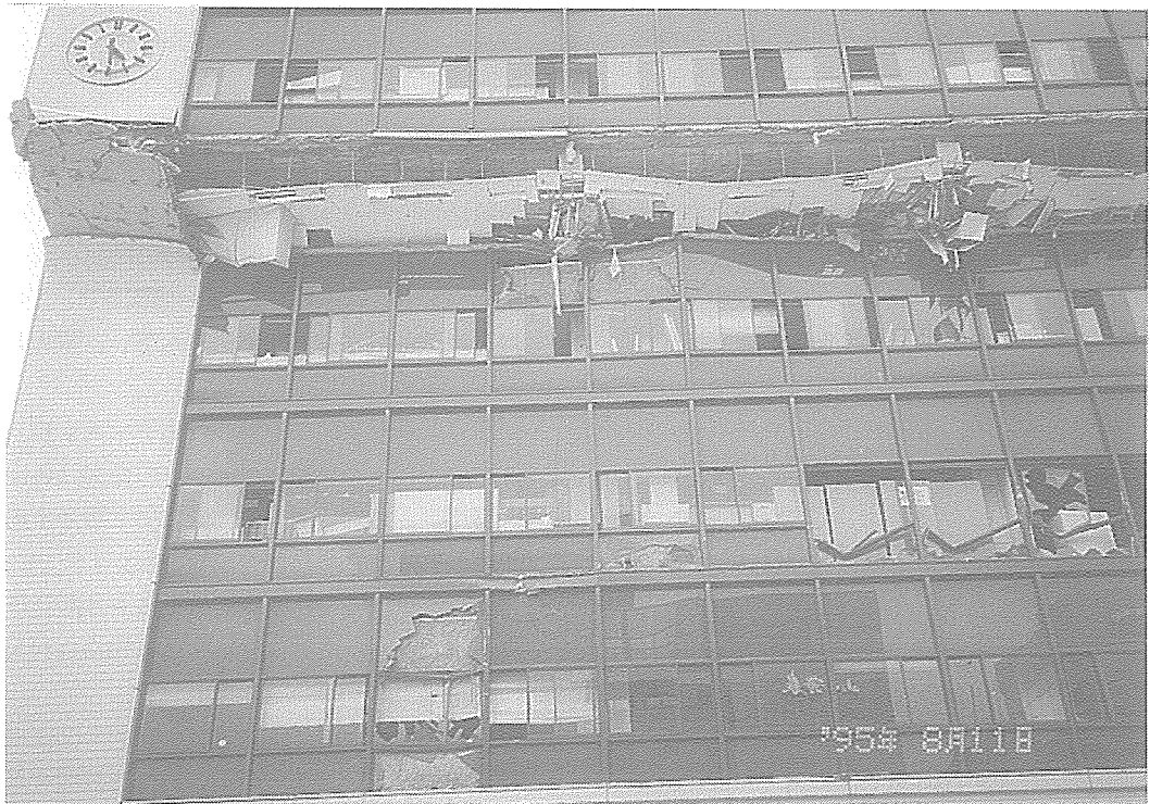
▲2号館：北側正面
